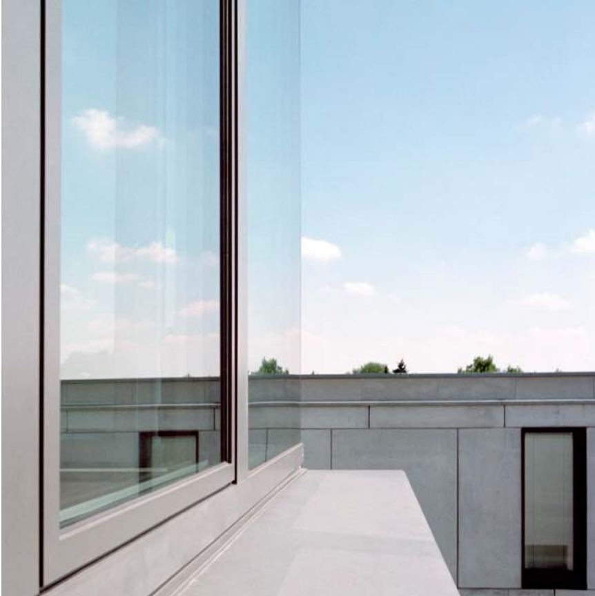
eine über Eck verklebte Glasecke
