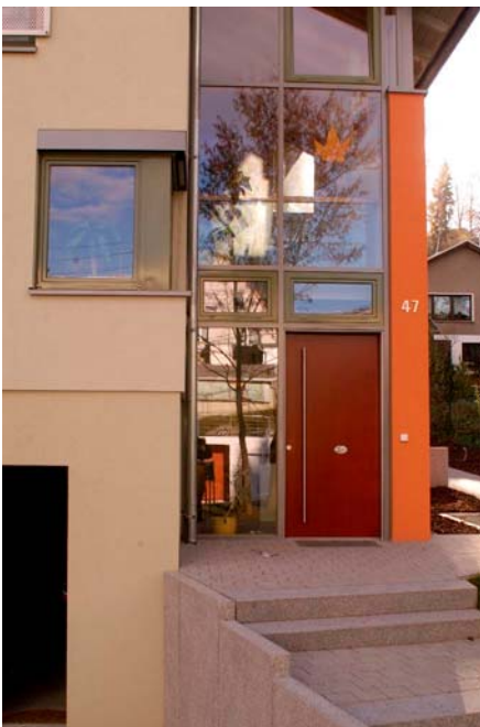
Pfosten-Riegel-Fassade mit integrierter Holz/Alu-Haustür
